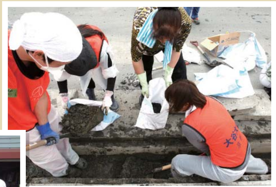
ヘドロで埋まってしまって排水がままならない側溝の掃除
